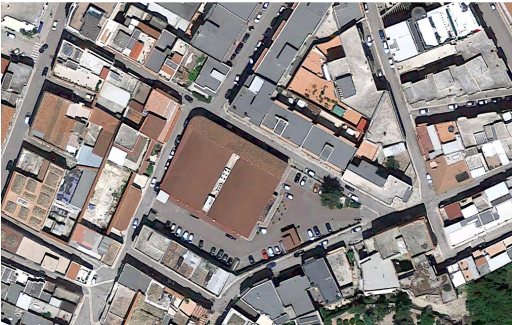
Media struttura in via Rovetta
