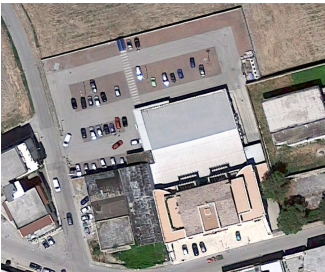
Media struttura in via Pozzillo
